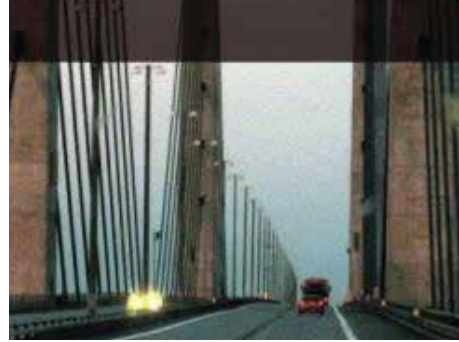
...Köprünün LYYN ile iyileştirilmiş hali
